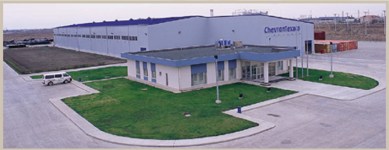
Chevron Polyethylene Pipe Plant – Завод пластиковых труб Chevron, Astana, Kazakhstan Астана, Казахстан
