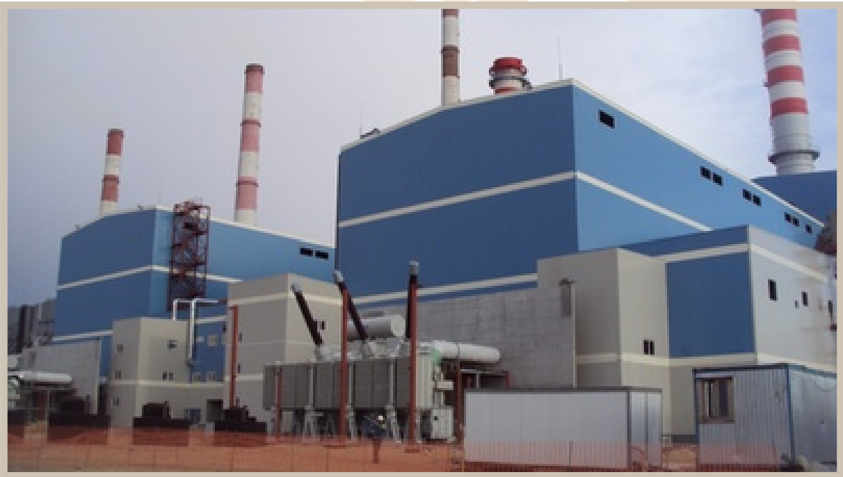
2x400 MW Combined Circle Power Plant ПГУ-800 МВт Сургутская ГРЭС, Россия – Surgut, Russia
