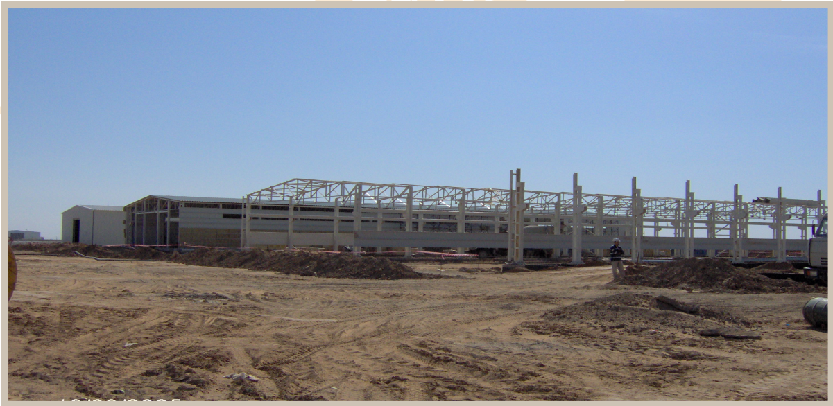
AGIP KCO Warehouses – Atyrau, Казахстан / Складской комплекс AGIP KCO, Атырау, Казахстан
